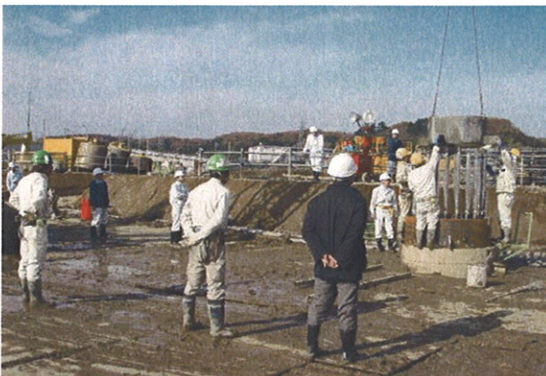
余盛コンクリート除去作業
