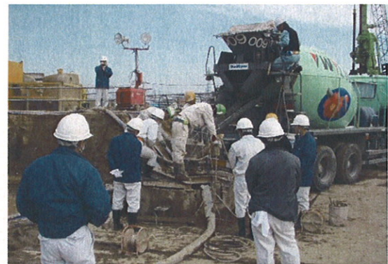
コンクリート打設状況確認
