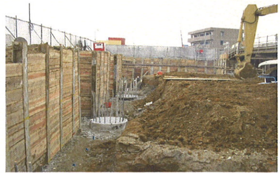
掘削作業後の杭頭状況
