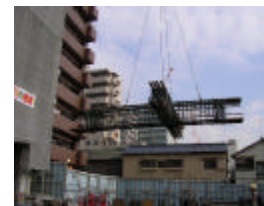
< 鉄筋先組み工法 >
