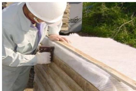
写真2 繊維植込みシート型枠貼付け
