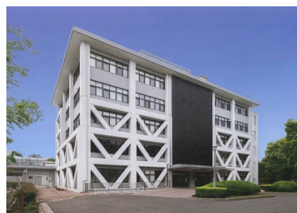
大学耐震改修
