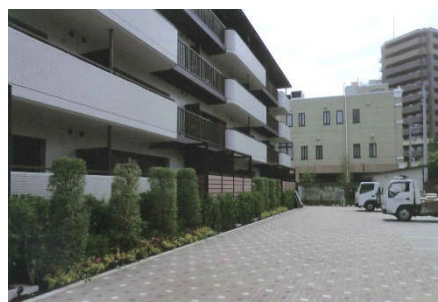
マンション(改修後)
