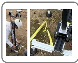
ハンディRTK 設置
