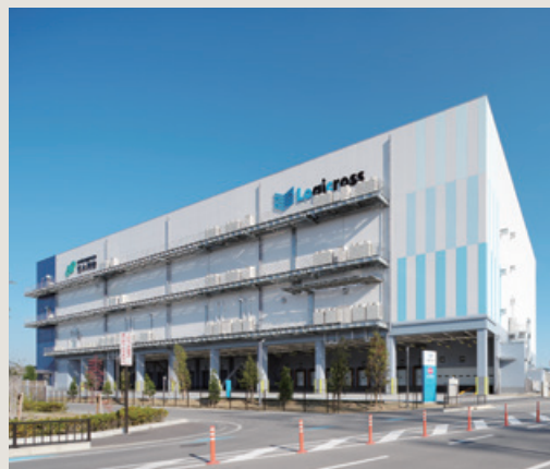
■ ロジクロス大阪交野開発計画新築工事 (大阪府)
