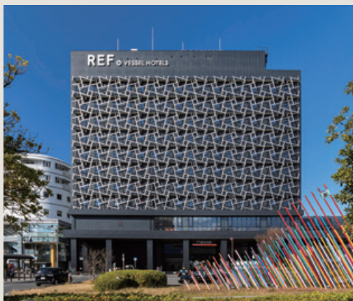
■ 泉佐野駅前交通広場における立体利用計画新築工事 (大阪府)
