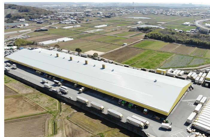
西濃運輸株式会社神明支店改修 /2021年3月
