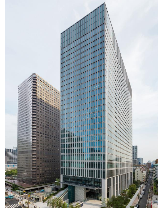
日本生命浜松町クレアタワー /2018年9月
