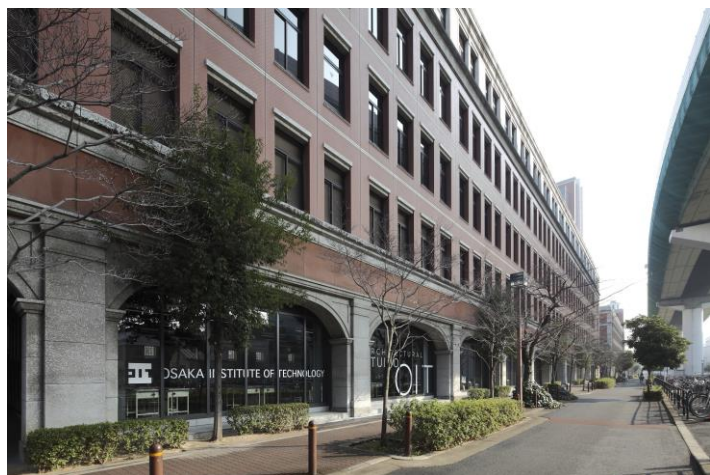
大阪工業大学大宮キャンパス2号館建築学科改造 /2018年2月
