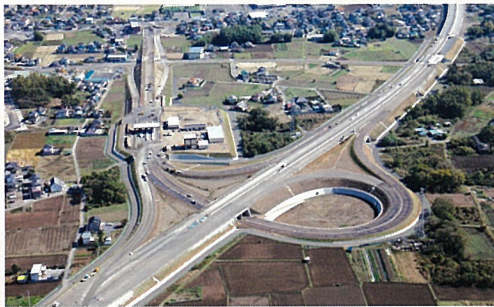
北関東自動車道田沼インターチェンジ（栃木県）
