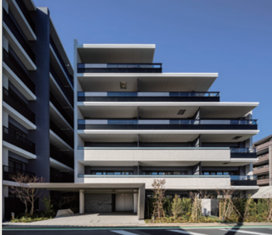
■ 朝霞台計画新築工事（埼玉県）
