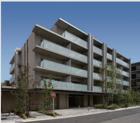
■ 芦屋市浜町PJ新築工事（兵庫県）
