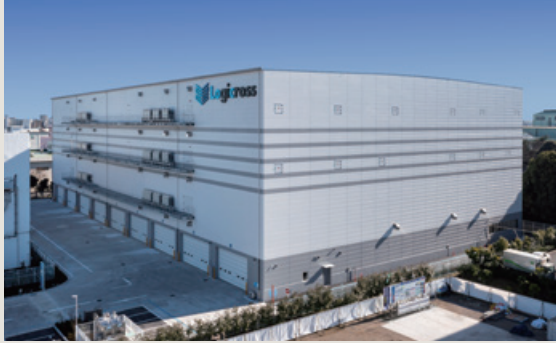
■ ロジクロス船橋計画新築工事（千葉県）
