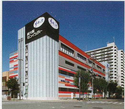
■ 新大阪センシティー新ビル新築工事（大阪）
