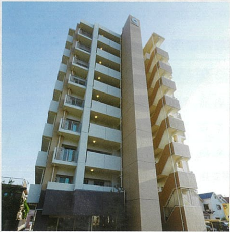
■ グラン・コート喜多山II新築工事（愛知）
