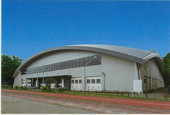
■ 千葉大学（西千葉）本部棟・体育館他改修その他工事（千葉）
