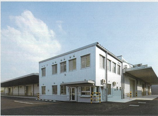
■ 日本梱包運輸倉庫株式会社奈良営業所新築工事（奈良）
