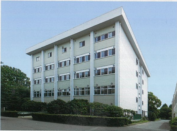
■ 千葉大学 (松戸) 園芸学部E棟改修その他工事 (千葉)
