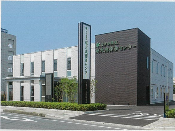
■ 東大成葬斎センター新築工事 (埼玉)
