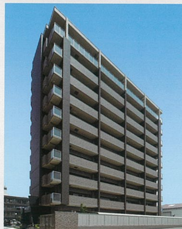
■ アルファステイツ南久米新築工事 (愛媛)
