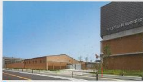
■ 守口市第二中学校・第四中学校統合校舎外新築工事（大阪）
