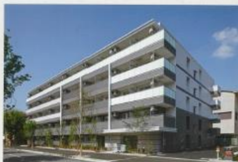
■ Cアミーユ阿川香榎園新築工事 (兵庫県)
