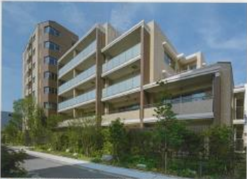
■ プラウドテラス公園パサージュ新築工事 (愛知県)
