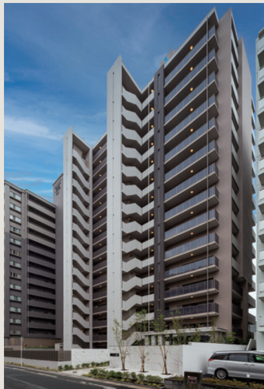
■ アルファステイツ永楽通り新築工事（鳥取県）
