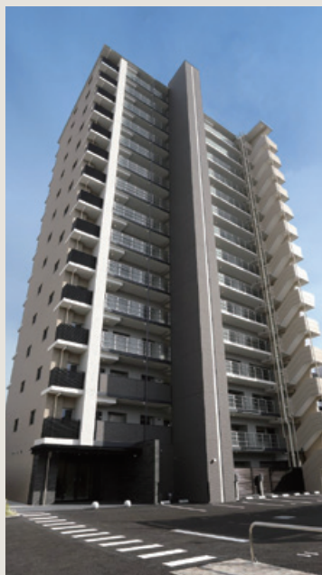
■ プレサンスロジエ草津若竹町新築工事 (滋賀県)
