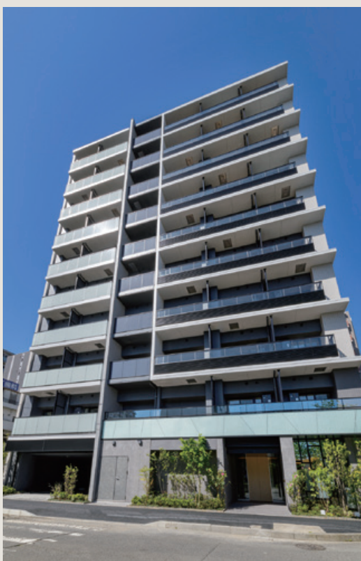
■ 阪東橋計画新築工事 (神奈川県)
