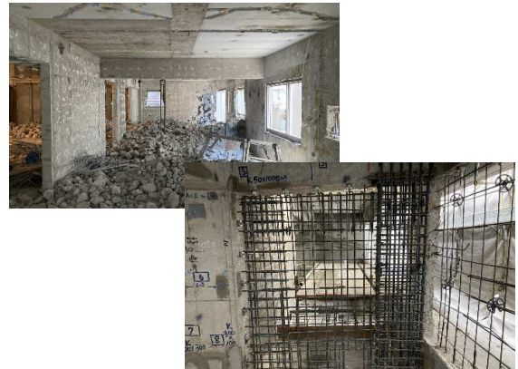
（躯体補修、新規壁配筋状況）
