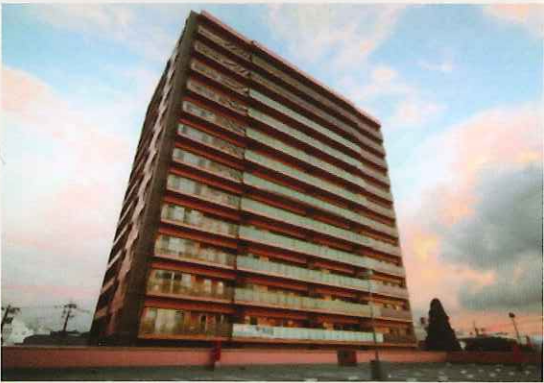
■ 上駅通り地区第一種市街地再開発事業 分譲棟及び商業・駐車場棟施設建築物新築工事（長崎県）
