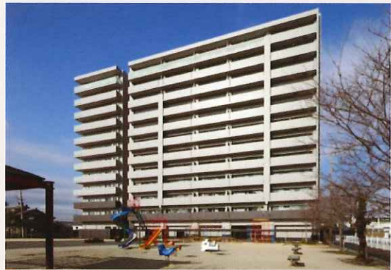
■ エスリード栗東駅前新築工事（滋賀県）
