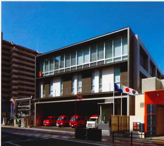
■ 東成消防署建設工事（大阪府）
