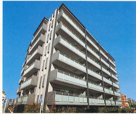
■ 東白楽マンション計画新築工事 (神奈川)
