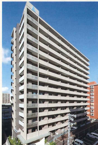
■ アルファステイツ岡山厚生町新築工事 (岡山)
