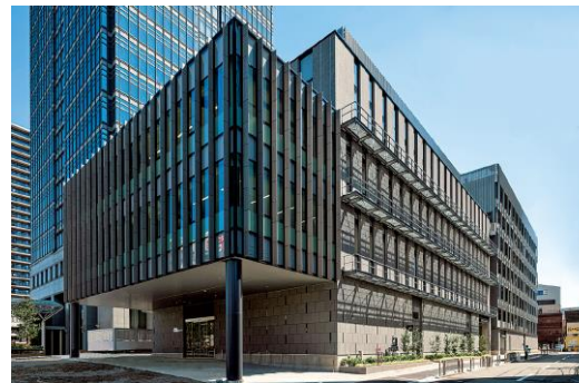
堺保健センター・市役所立体駐車場 /2021年9月
