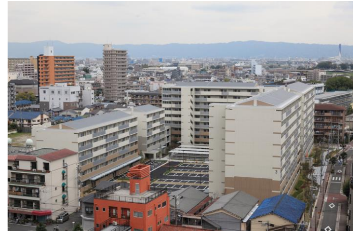
大阪府営苅田住宅/2009年11月
