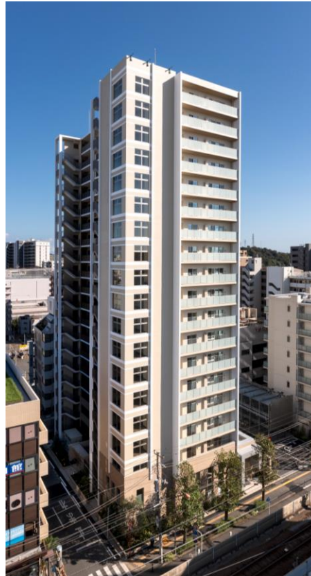
FUJISAWA THE TOWER /2021年11月
