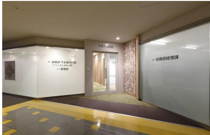
ATC・ITM棟改修/2011年8月
