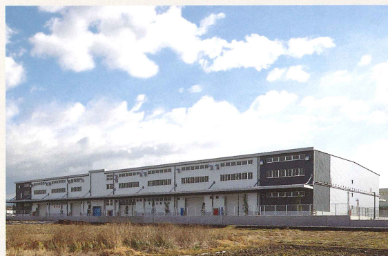
■ 日本梱包運輸倉庫株式会社奈良営業所大和郡山出張所新築工事（奈良県）
