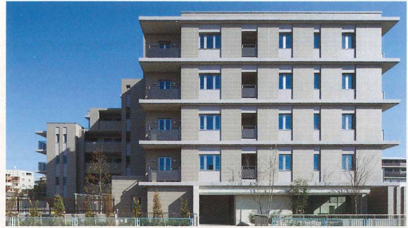
■ ジオ西宮北口樋ノ口町新築工事（兵庫）
