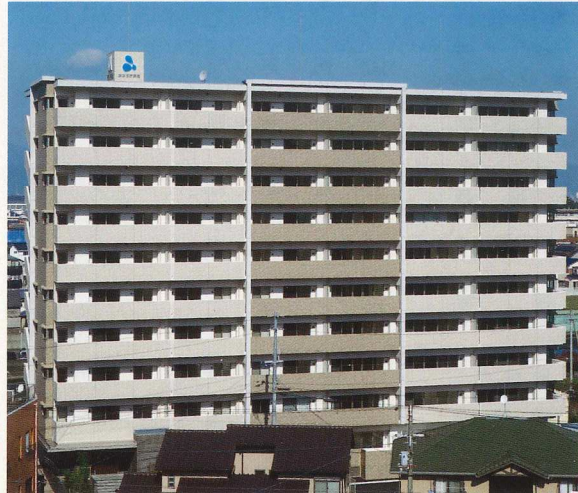
■ アルファステイツ佐古Ⅱ新築工事（徳島）
