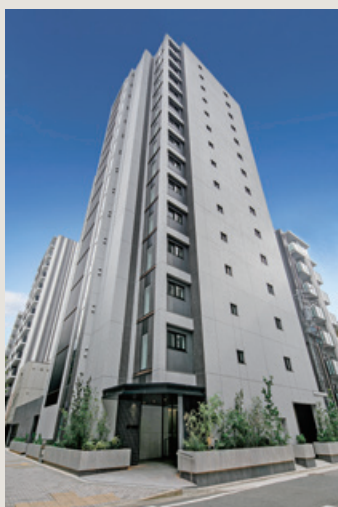
■ 西区那古野一丁目PJ建設工事（愛知県）
