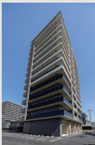
■ クレアホームズ長束新築工事（広島県）
