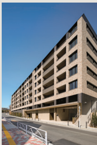
■ 目黒大橋マンション計画分譲棟新築工事（東京都）
