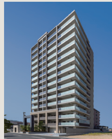
■ アルビオ・ガーデン新倉敷駅前新築工事 (岡山県)
