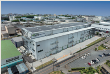
■ T-LOGI鶴ヶ島新築工事 (埼玉県)
