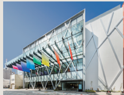
■ 宮元町第二地区優良建築物等整備事業建設工事 (群馬県)
