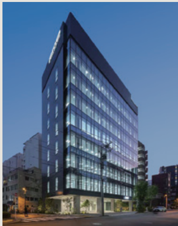
■ PMO秋葉原Ⅲ新築工事 (東京都)
