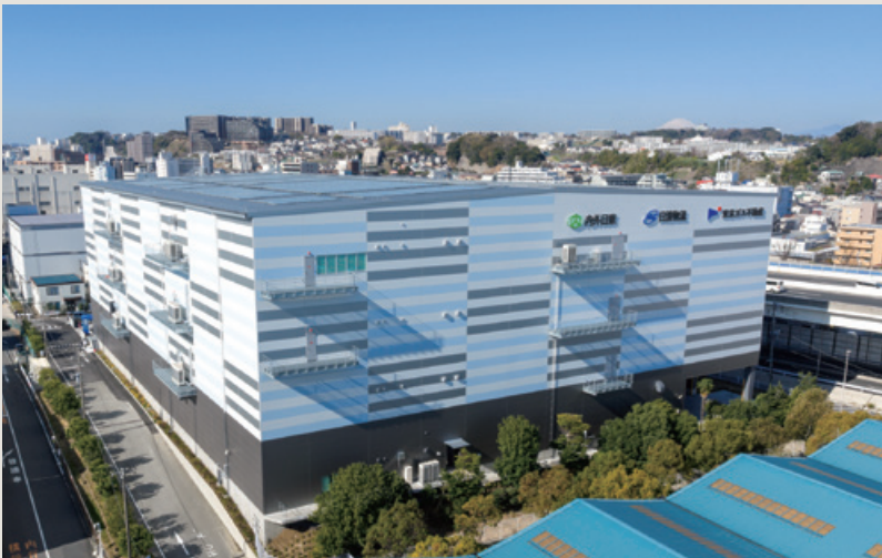
■ 根岸物流施設プロジェクト新築工事（神奈川県）
