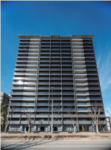
■ レーベン福島太田町新築工事（福島県）
