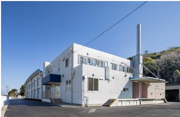
阪南市立学校給食センター/2025年1月
