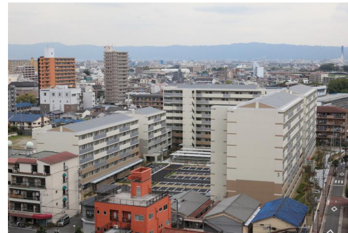
大阪府営苅田住宅/2009年11月
