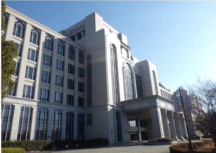
大阪工業大学枚方キャンパス1・2号館外壁改修 /2020年12月
